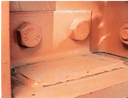
Khớp nối chốt đỉnh và mặt đế ( Bolted Top and Seat Shear Connection )
