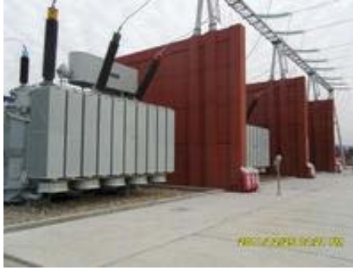
220 kV impedance matching power transformer Máy biến áp phối hợp trở kháng 220 kV
