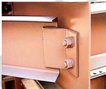
Khớp nối chốt sàn và rầm kép ( Double Web Angles Shop and Field Bolted Shear Connection )
