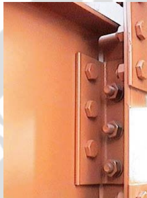
Khớp nối chốt sàn và rầm kép ( Double Web Angles Shop and Field Bolted Shear Connection )
